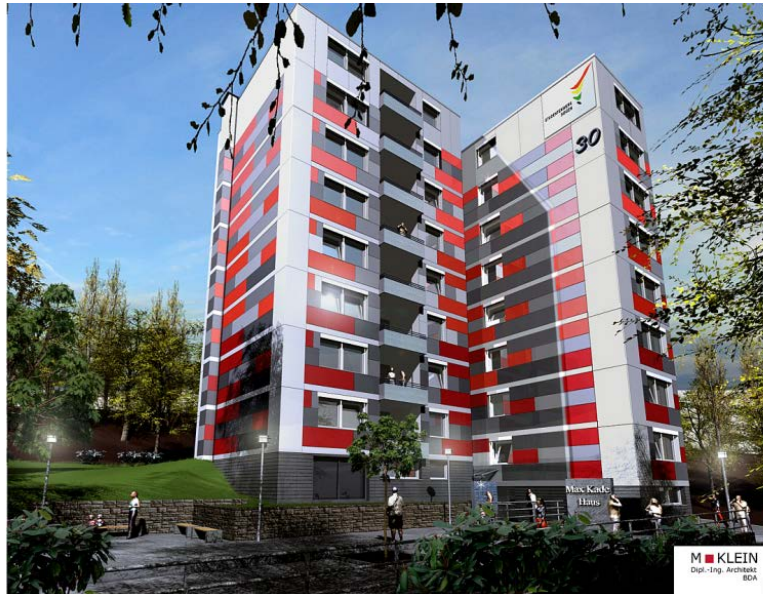
Max-Kade-Haus nach Sanierung
